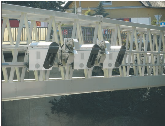
In der Alpenrepublik ist die abschnittsweise Geschwindigkeitskontrolle an mehreren Stellen auch stationär verbaut (Foto). Die Technik trägt entscheidend zur Verkehrssicherheit bei.
